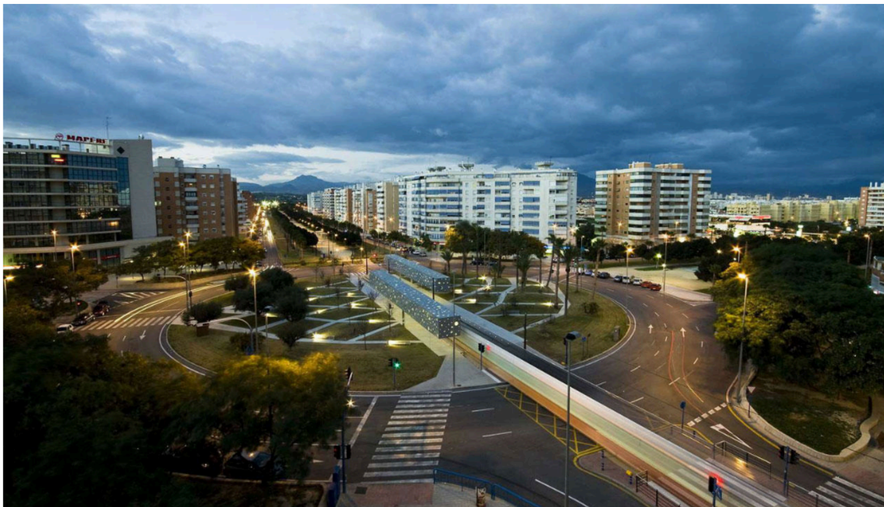
Fermata del tram ad Alicante (Spagna) che rappresenta un vero nodo urbano in una piazza verde progettata nel dettaglio. Progetto Subarquitectura
